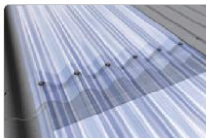
PARTICOLARE SOVRAPPOSIZIONE detail of overlapping components.
